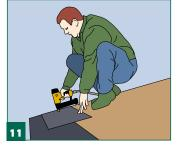
Zum Schluss werden die Aluschienen auf Gehrung gekürzt und zusammen mit dem Ortgangsbrett montiert. Dann die **Dachschindeln** mittels Tacker oder Hammer aufnageln, dabei ist auf eine ausreichende Überlappung der einzelnen Schindeln zu achten
