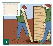
Nach dem Einsetzen der Platten wird der nächste Pfosten **passgenau** an die Elemente angesetzt und lotgenau ausgerichtet und einbetoniert.
