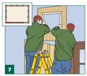
Die beiden letzten vorderen Motivplatten werden von oben zwischen die Pfosten eingelassen. Wenn alle Platten eingesetzt und die beiden letzten Pfosten ausgerichtet sind, diese dann einbetonieren. Der Beton der Fundamente sollte, bevor mit den Dacharbeiten begonnen wird, mindestens **24 Stunden trocknen**.
