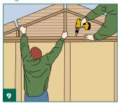
Das schon fertig zusammengesetzte **Giebelelement** wird nun auf dem Ringbalken ausgerichtet und verschraubt sowie die Fenster, mit der Holzleiste nach außen, passgenau eingesetzt.
